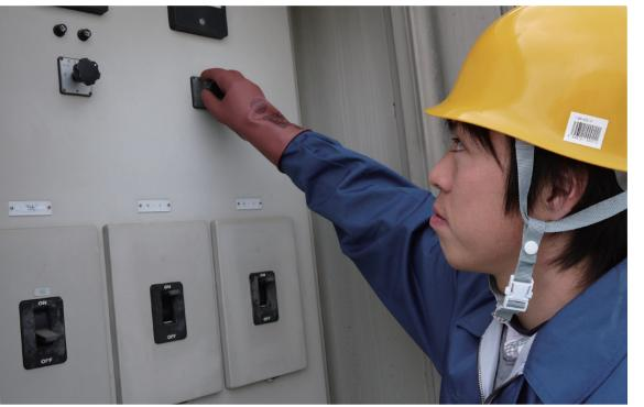
キューピクル内低圧盤電流測定
